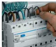
Монтаж проводки производится быстро и надежно благодаря фазным шинам
