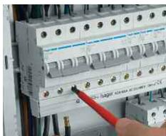
Одновременное присоединение фазной шины и проводника при помощи Bi-Connect клеммы
