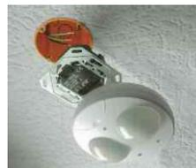
Простая установка устройства в стандартную коробку для скрытой проводки
