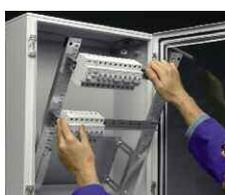
Монтаж и подключение производятся вне корпуса. По окончании этих работ несущая рама защелкивается в щитке на своем месте, а затем прикручивается.
