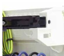
Установка клемм на защёлке
