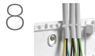
Разгрузка кабеля от натяжения (крепление кабеля для предотвращения непреднамеренного вытягивания) при помощи кабельных зажимов.
